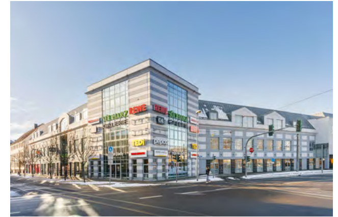
Außenansicht Südharz Galerie
